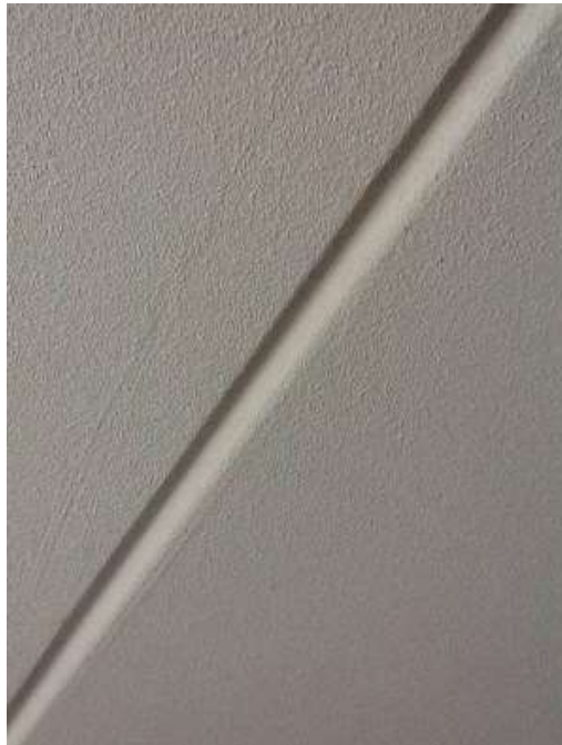
Referentiebeeld Plafondafwerking Base Line Spackspuitwerk kleur wit met V-naden in het zicht
